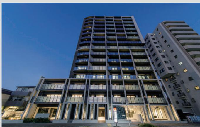
高層棟と低層棟をL型に配置した平面形状とし、国道沿いに高層棟のメインファサードを向けた計画としている。斜め形状の躯体マリオンが各階でリズムカルに天空へ伸びていく形状に適宜アルミシルバー色にてアクセントを取り入れるデザインとしている。
